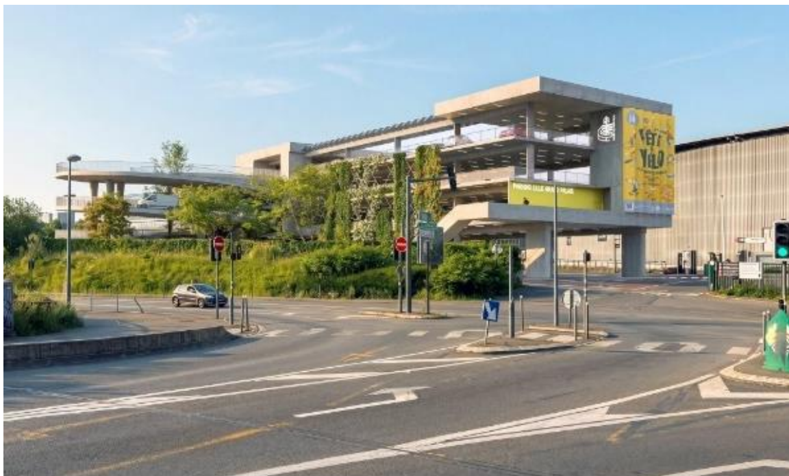
VUE DEPUIS L'ENTRÉE DU SITE —
