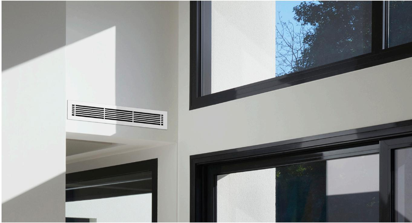
Les gainables sont les plus invisibles des solutions de pompes à chaleur Air/Air puisque les unités intérieures se trouvent soit dans les combles, soit dans un faux plafond grâce à leurs dimensions compactes (20 cm d'épaisseur et 79 cm de largeur). Des grilles discrètes diffusent l'air frais (ou chaud selon la saison)
