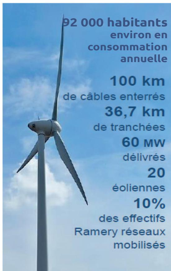
Aujourd'hui, Ramery réseaux réitère la performance sur le parc de Douiche. Mobilisant une vingtaine de ses collaborateurs, soit 10 % de ses effectifs, l'entreprise assure en 7 mois l'enfouissement de 100 km de câbles dans 36,7 km de tranchées. Pour permettre le raccordement de 20 éoliennes dans un délai serré, 1 km de travaux aura ainsi été achevé chaque semaine !
